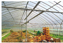
▲写真1 ハウスの補強
