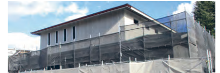
▲ 工事中的新 岩倉支店
