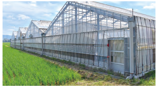
▲30アールの鉄骨ハウス
